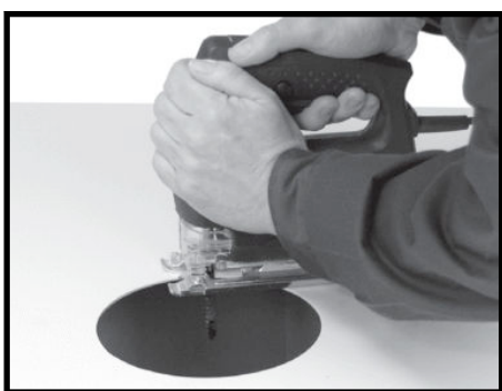
Trin 4. Skær udsugningshul i maskinkabinettet.
